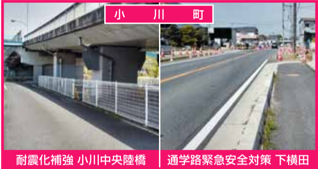
小川町 耐震化補強 小川中央陸橋 通学路緊急安全対策 下横田
