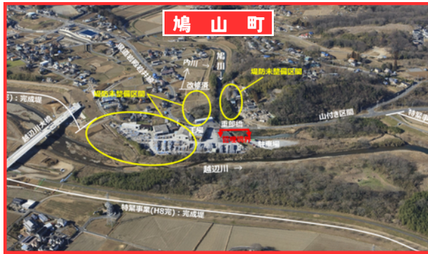
鳩山町における堤防未整備区間の早期完成
